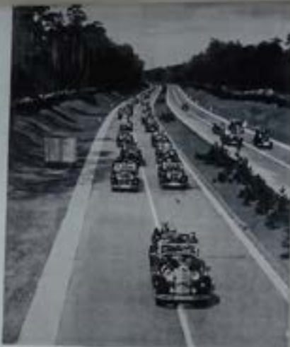
Der Führer steuert die Reichsautobahn Frankfurt am Main - Wiesbaden am 10. Mai 1933
